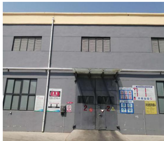
丙类暂存库外貌
