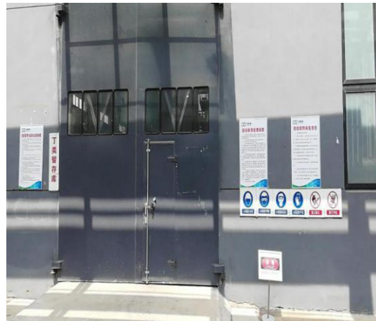
丁类暂存库外貌
