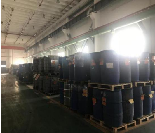
丙类暂存库内部分区
