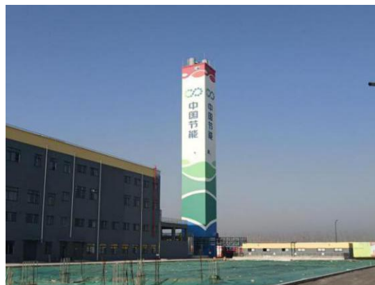
焚烧废气排气筒现状照片
