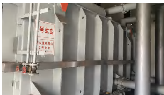
图 4-8 2#主变压器
