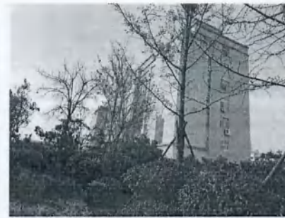
图6 变电站西侧 6m 中国人寿公司办公楼
