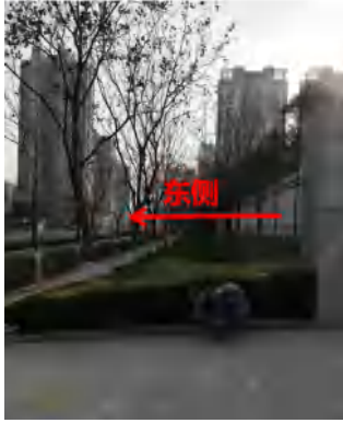
图 4-3 明望台 110kV 变电站东侧
