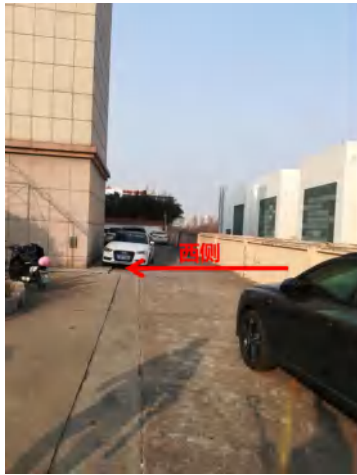
图 4-5 明望台 110kV 变电站西侧
