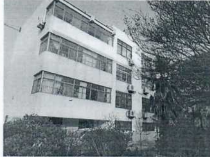
图 7 变电站西北侧 13m 中国人寿小区 1 号楼
