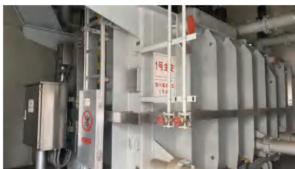
图 4-7 1#主变压器
