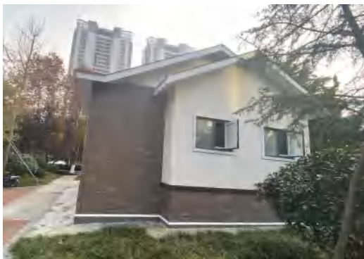
图 2-1 变电站南侧 19m 环卫休息室
