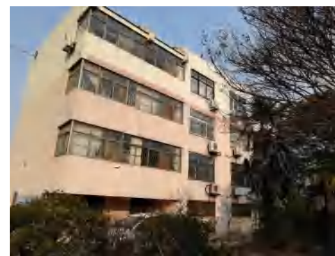
图 2-3 变电站西北侧 13m 中国人寿小区 1 号楼
