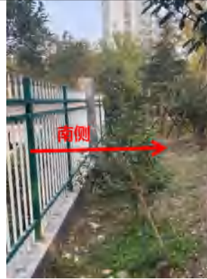
图 4-4 明望台 110kV 变电站南侧
